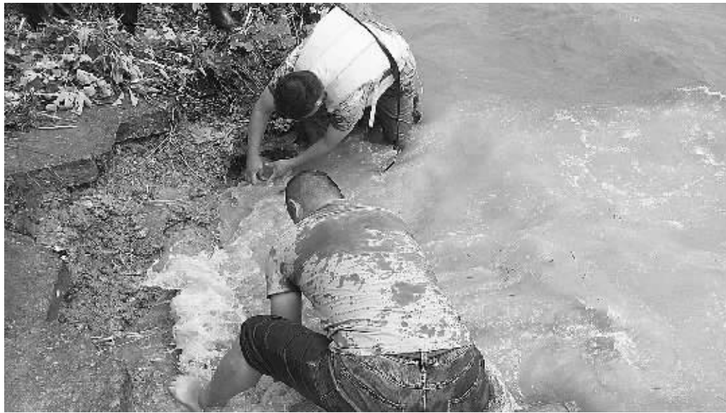
吁连泉(上)与刘强华合力堵住防洪墙缺口
